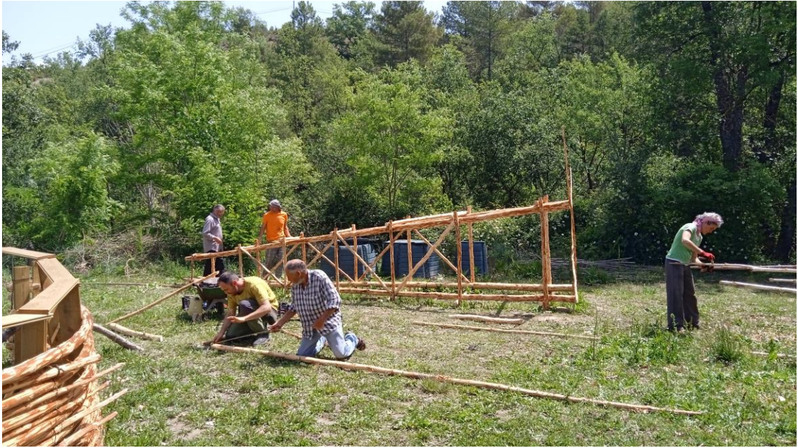
Terminando de montar la torre energética
