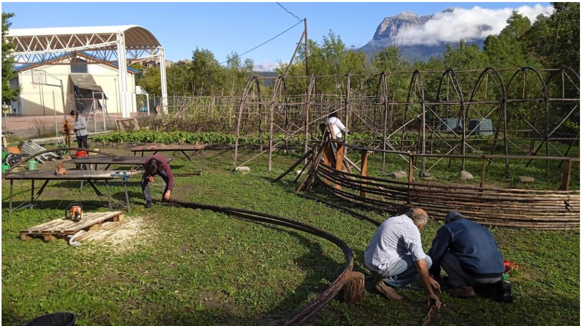
Armado de los primeros arcos para la cúpula
