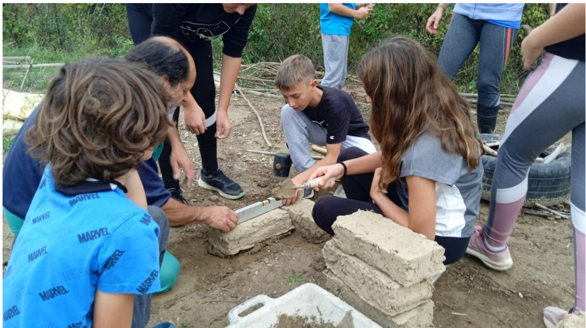
Enseñando a construir pared con los adobes
