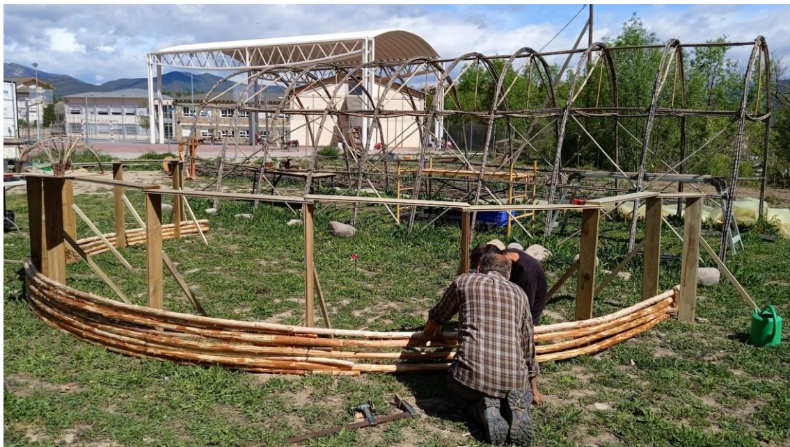
Construida la cimbra en el suelo, curvado y amarre de los troncos para secar
