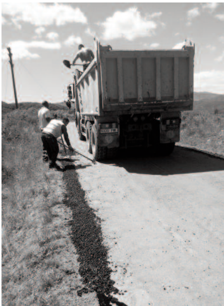
Trabajos de asfaltado.
