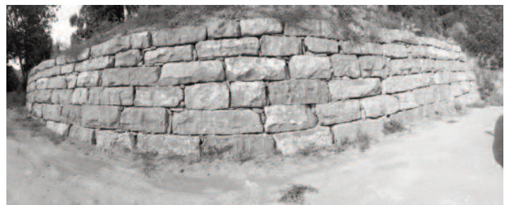
Muro de contención en San Ciprián (Banastón).
