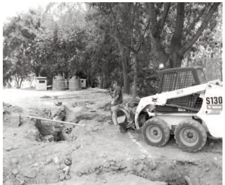
Trabajos en el aparcamiento.
