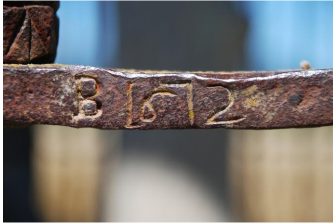
Detalles de la verja forjada en 1672 sin soldaduras ni tornillos.
